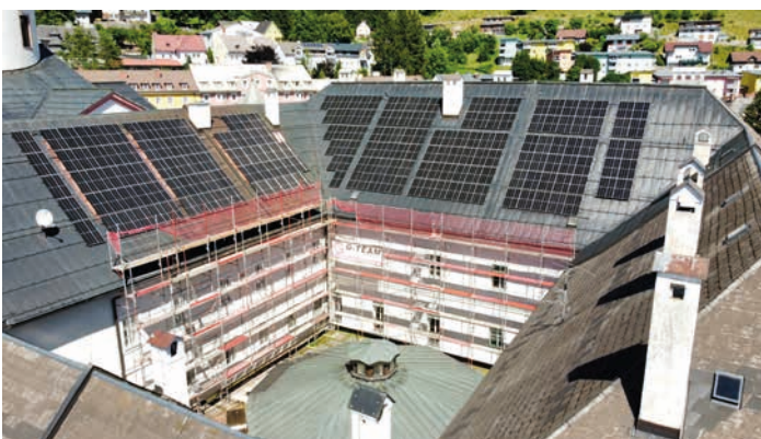
Eine großflächige Photovoltaikanlage wurde an den innenseitigen Dachflächen des Geistlichen Hauses angebracht.
