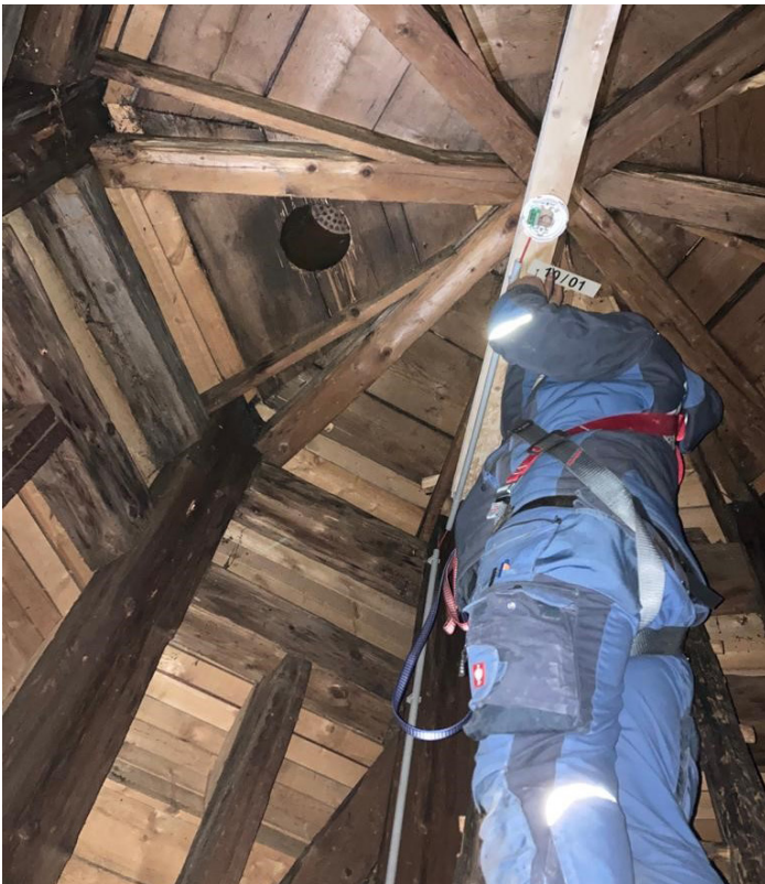
Der Austausch der Brandmelder war eine große Herausforderung. Besonders im Turmbereich der Basilika mussten große Höhen überwunden werden.
